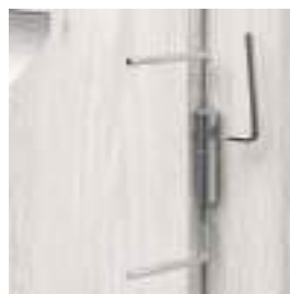
regulacja zawiasów czopowych regulowanych 3D
