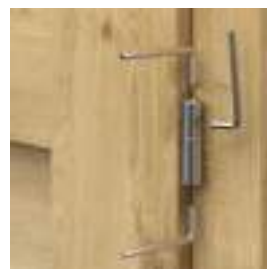
regulacja zawiasów czopowych regulowanych 3D
